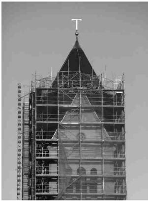
Schwerlast-Stahlträgern nötig. Aber wie konnte das Gewicht aus einem etwa 30 m hohen Gerüst auf der Turm-Ostseite über dem Dach des Hauptschiffs abgefangen werden, ohne dieses Dach zu belasten? Die Gerüstbauer und ihre Statiker fanden eine pfiffige Lösung: Mit Schwerlast-Gitterträgern wurde zwischen dem Fassadengerüst an der Hostatostraße und dem Turmgerüst auf der Nordseite eine Brücke gebaut. Als Nord-Auflager musste dazu eigens eine aus Stahlprofilen zusammengesweißte Schwerlast-
